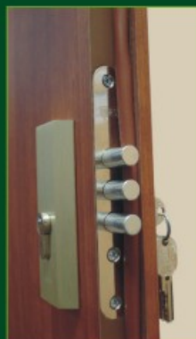
Pridavný zadlabávací trojbodový zámok
